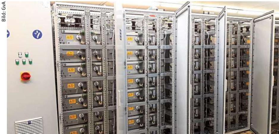
Bild 3: Gewaltige Kondensatorbänke von GvA puffern die benötigte Energie.
